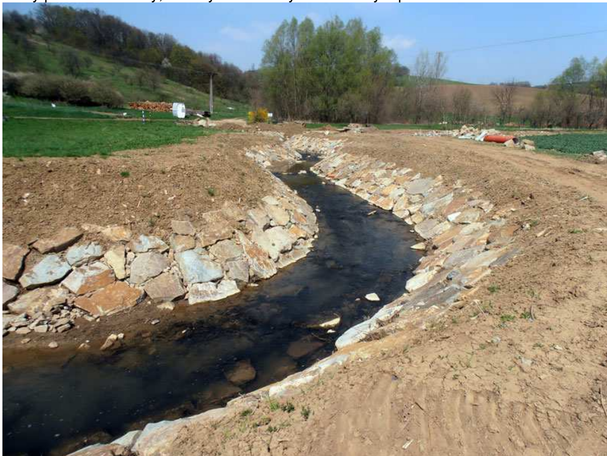
Vzorová ukázka kamenné rovnaniny s vyklínováním
